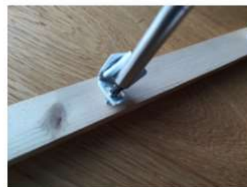
Pose murale avec équerre invisible : Fixer l'équerre avec le support universel sur le mur
